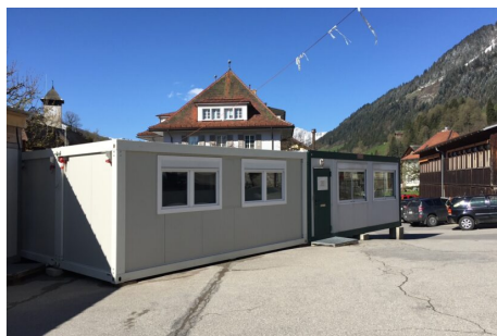
Un des containers de dégagement dans la cour du collège © Jean-Jacques Burri
